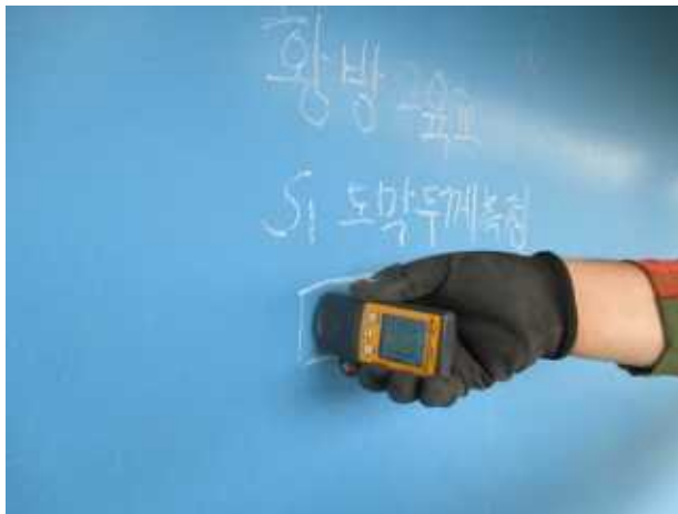
거더 외부 도막두께 측정
