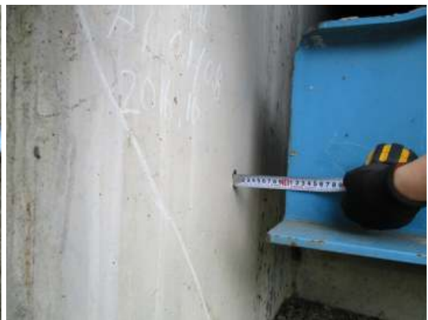
신축이음 유간거리 측정
