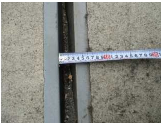
신축이음 유간거리 측정
