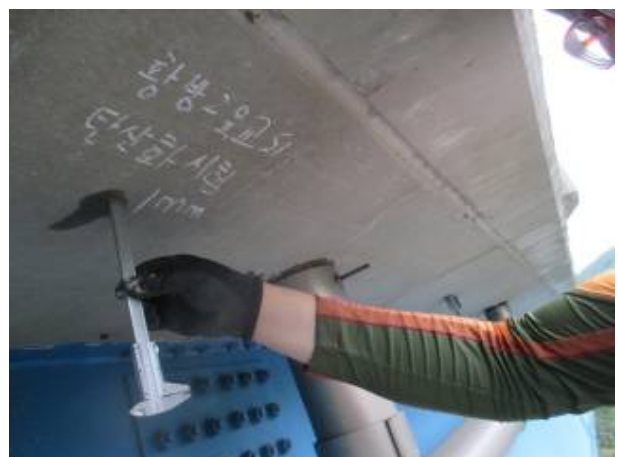
콘크리트 탄산화시험(탄산화 깊이측정)
