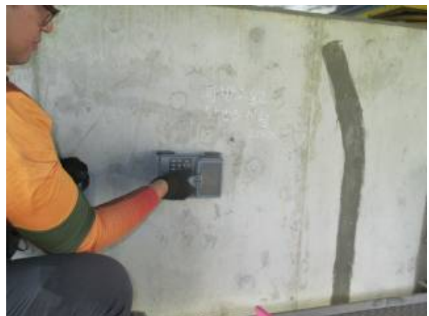
철근 피복두께 측정
